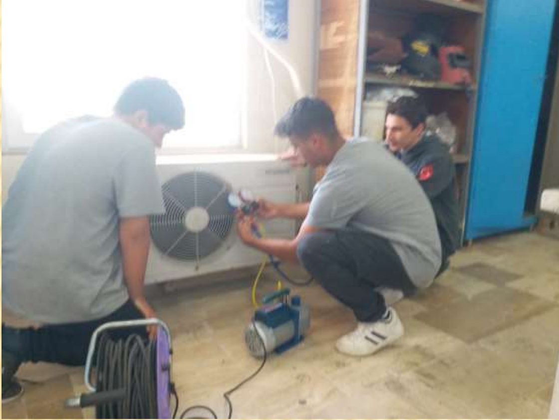
Klimaya Gaz Basma Öncesi Vakumlama Uygulaması
