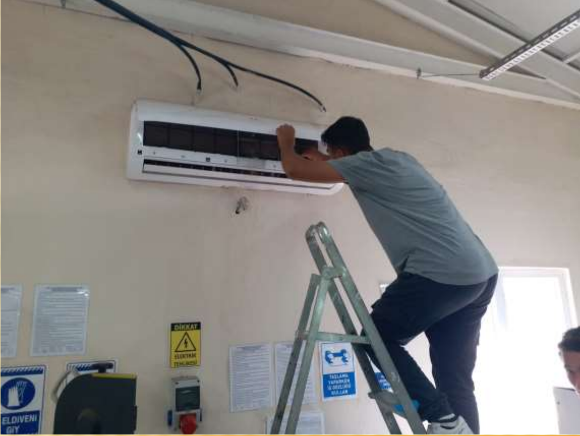
Klima Bakım Uygulaması
